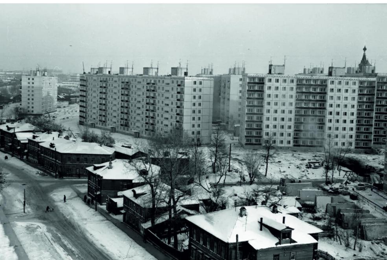
Илл. 19. Раздел обеспечения сохранности памятника археологии «Культурный слой города» Нижнего Новгорода для проектной документации: «Строительство апарта-отеля по адресу: г. Нижний Новгород, Нижегородский район, ул. Провиантская, д. 16а (литеры В, Д)». Ул. Ковалихинская. Фото 80-х годов XX в.
